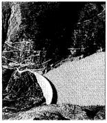
A livelli quantitativi molto elevati, lo stoccaggio energetico è ottenuto azionando pompe elettriche che sollevano acqua da un bacino inferiore a un bacino idroelettrico ad altezza superiore. Con un kilowattora si solleva un metro cubo di acqua all'altezza di 367 metri
