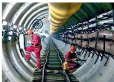
AMBIENTE Operai al lavoro all'interno di un gasdotto
